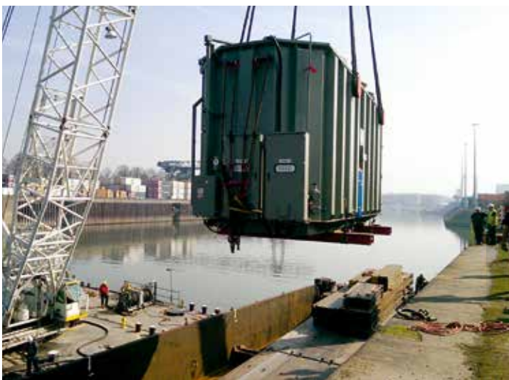
2016 soll das neue Gas- und Dampfturbinenkraftwerk Niehl 3 in Betrieb gehen.
