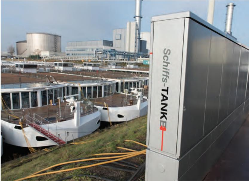
Seit 2015 können in Köln Schiffe über Schiffs-TankEn mit Strom aus erneuerbaren Quellen versorgt werden.
